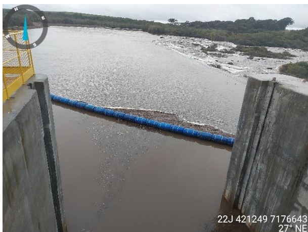
Figura 6: Sistema de log boom e limpa grades da PCH Taguá.
