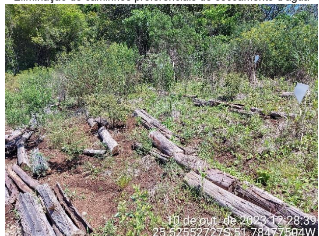
Eliminação de caminhos preferenciais de escoamento d'água
