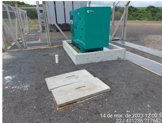
Figura 3: Tanque séptico localizado ao lado da subestação da PCH Taguá.
